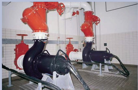
Bombas instaladas horizontalmente con camisa enfriadora.
